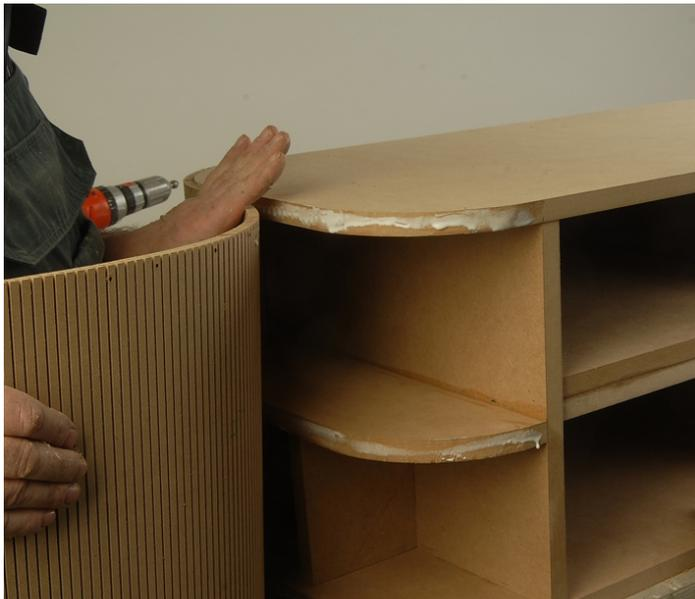
Découpez une bande de MDF flexible à la bonne hauteur. Prévoyez aussi des trous préforés à des intervalles réguliers. Fixez-le d'un côté avec une vis, aussi bien en bas qu'en haut. Veillez à ce que les vis soient complètement enfoncées dans le MDF flexible, en utilisant une fraise conique lors du préforage. Appliquez de la colle à bois sur les bords du meuble.
