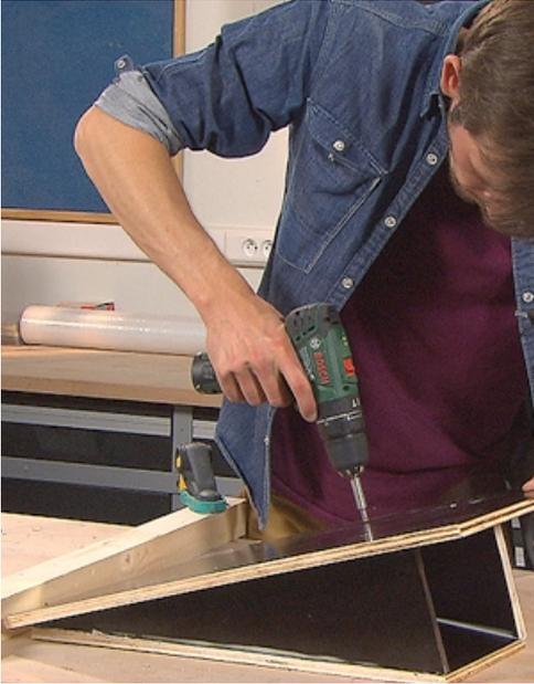
Pour éviter que le mélange de ciment ne s'infilte dans les fissures, faites en sorte que les différentes planches s'emboîtent correctement. Veillez donc à pré-percer avant de visser. Il est également utile d'appliquer de la colle à bois ou du ciment universel dans les joints.
