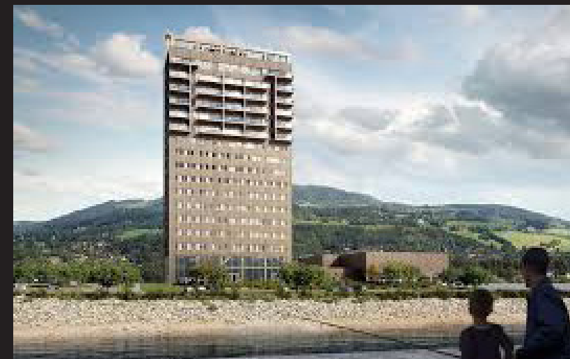
Mjøstårnet Brumunddal, Uitvoering 2017-2019 18 verdiepingen Kern hout in combinatie met houten vakwerk
