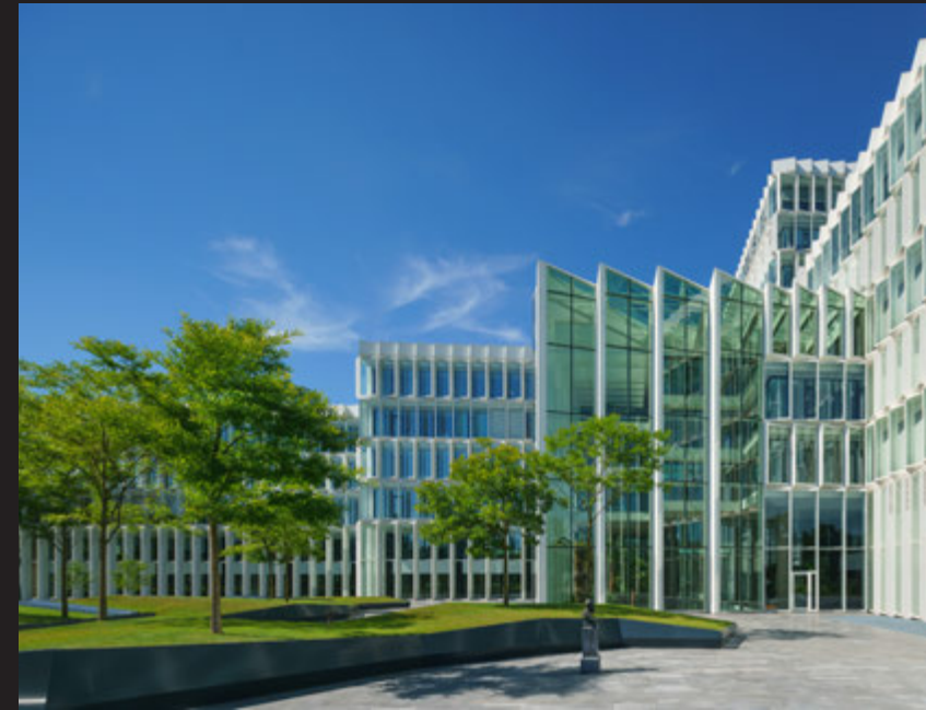
Renovatie Hoofdkantoor ASR, Utrecht
