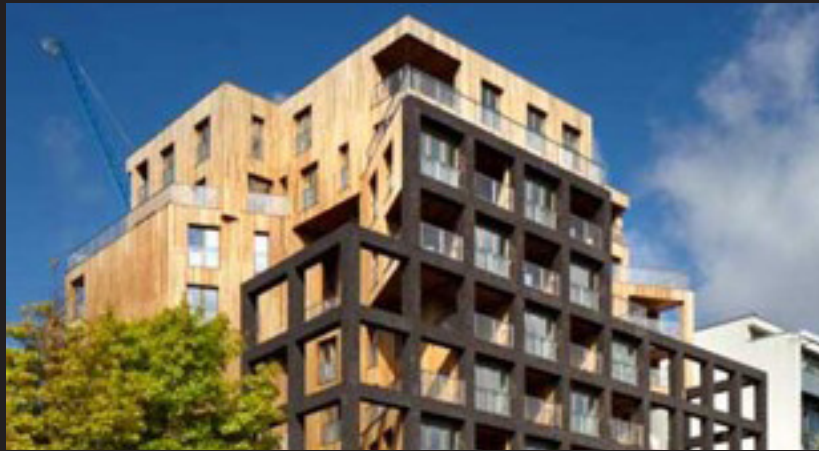
Banyan Wharf London, Opgeleverd 2015 10 verdiepingen Kern in beton
